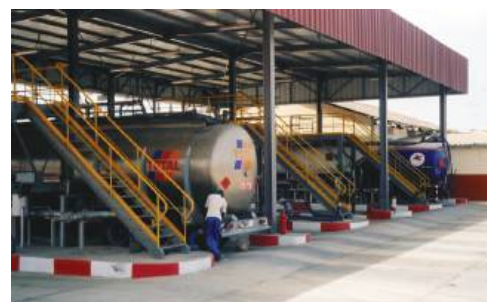
Postes de dépotage des bridgers de Jet A-1 à la SMCADY
