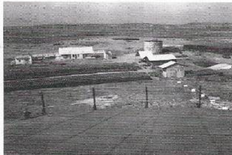
Vue du dépôt du haut du bac de 5000 m3 : des régiments de fûts pour faire face à la demande sur 9 mois...
