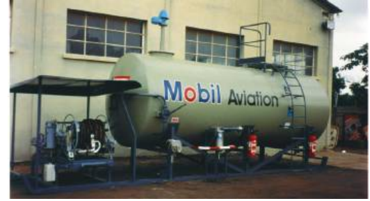
Ensemble complet de distribution d'Avgas 100
