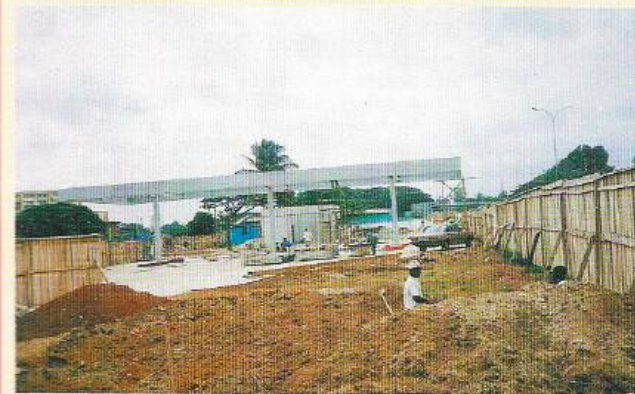
Construction de la station-service "Piscine Municipale" à Abidjan.
