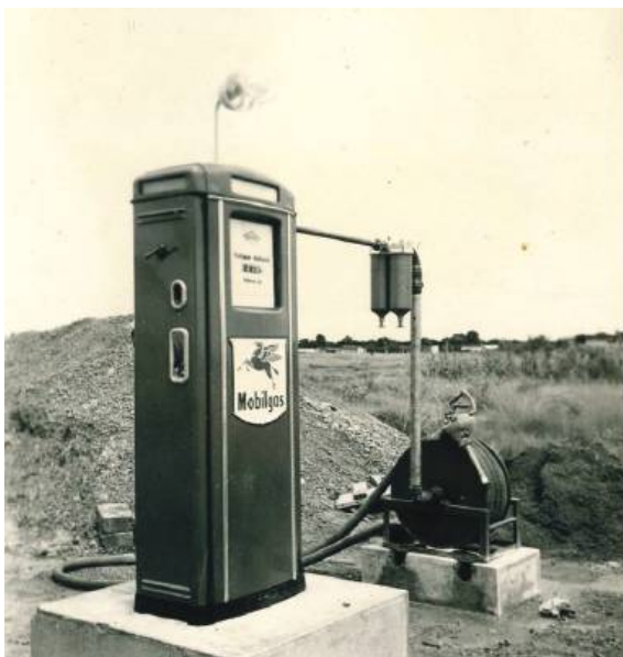
Aéroport d'Ouagadougou : Poste de livraison de l'essence avion (Avgas).
