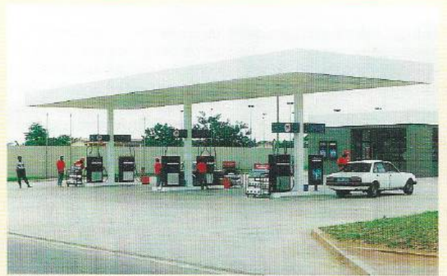
Station-service de Latriile à Abidjan.
