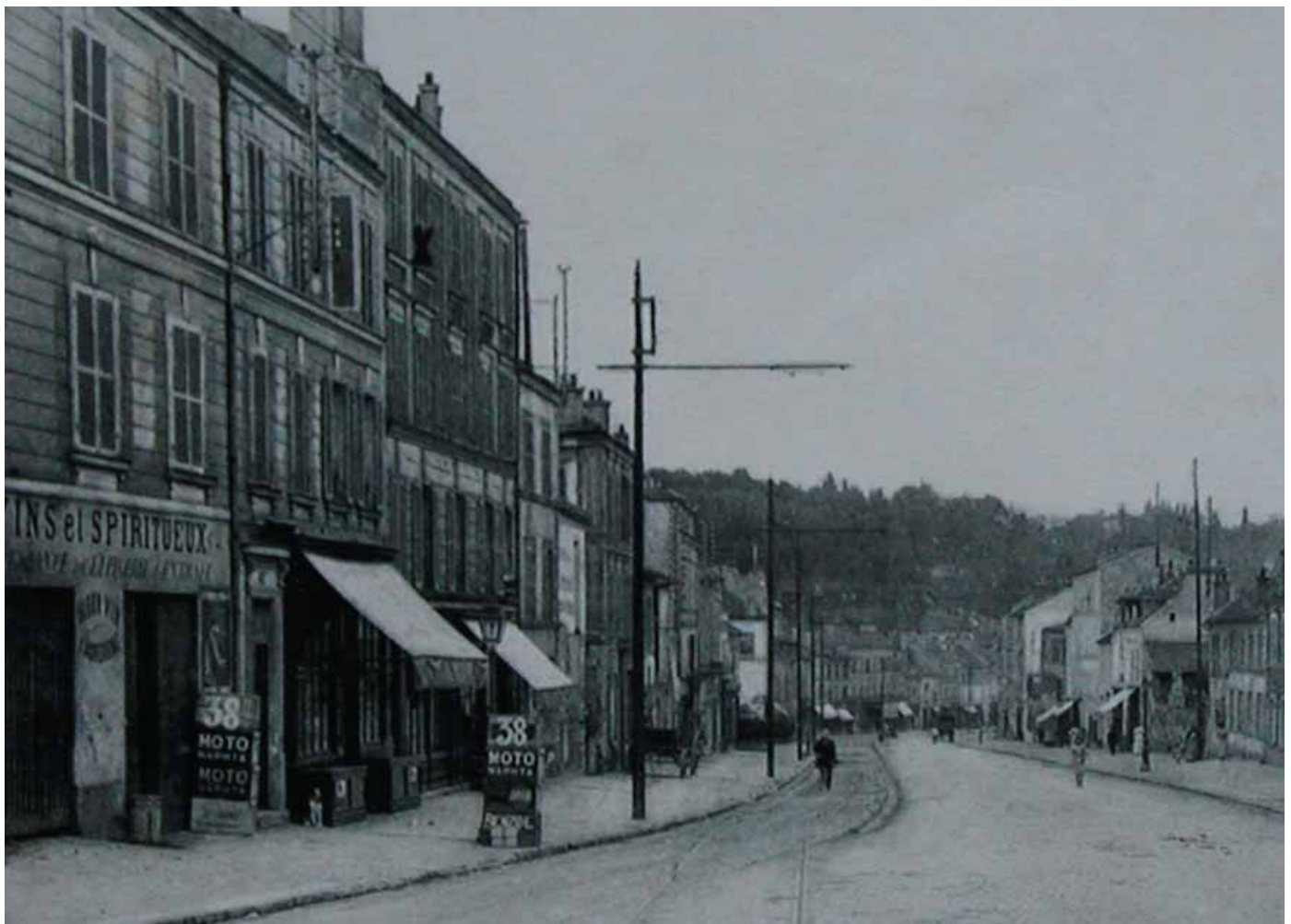
Ce sont les petits commerces, très fortement implantés, comme ici une épicerie, qui vendent les premières essences pour automobiles. Les caisses de Moto Naphta, produit par la société Deutsch de la Meurthe, fleurissent partout devant les vitrines.
