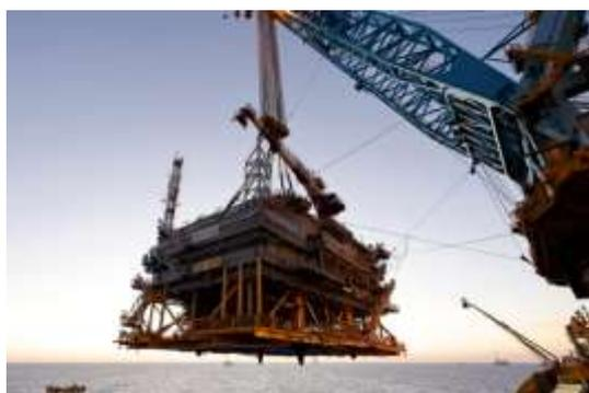
Installation de la sous-station électrique de 3 400 tonnes du futur parc éolien offshore au large de Saint-Brieuc. (©Iberdrola)
