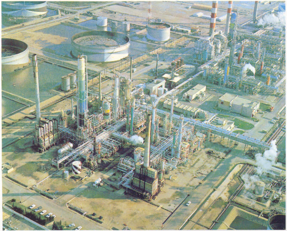
1979 : la raffinerie Esso de Fos-sur-Mer.
