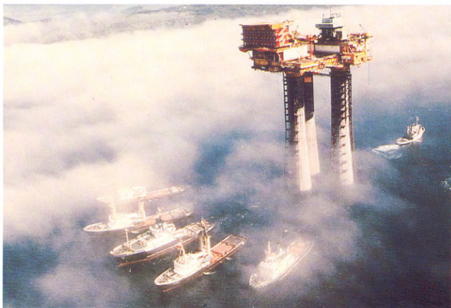
Remorquage d'une plate-forme d'exploitation vers un gisement en mer du Nord.
