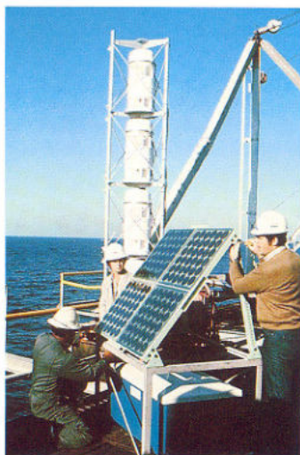
Panneau de cellules solaires.
