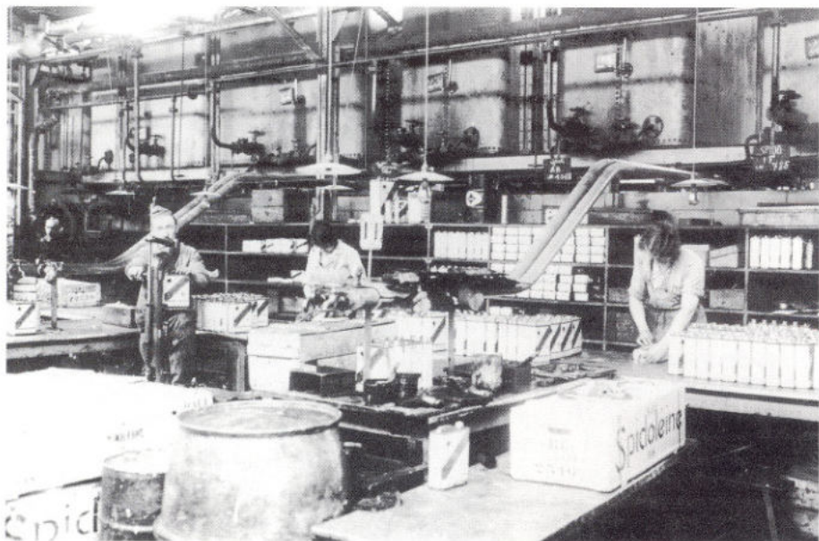
Mise en bidons d'huile Spido à l'usine de Dunkerque.
