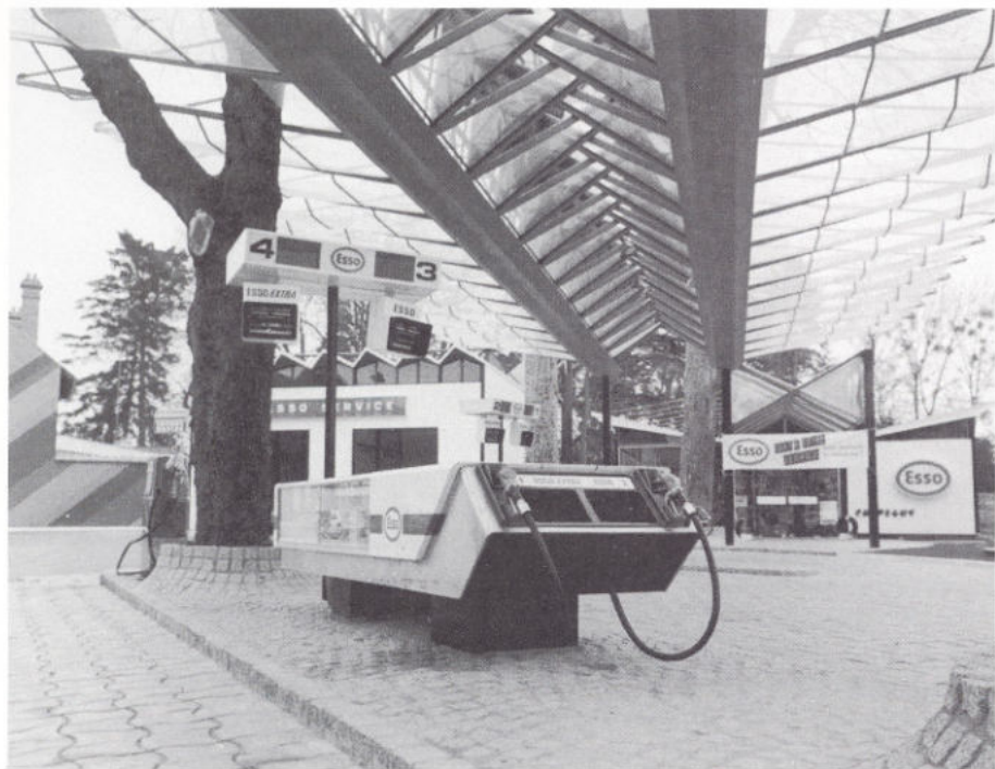
Une station-service récente, la station Charles Péguy, près d'Orléans.
