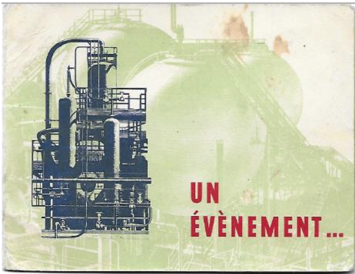
Unité de déparaffinage et désasphaltage de PJ
